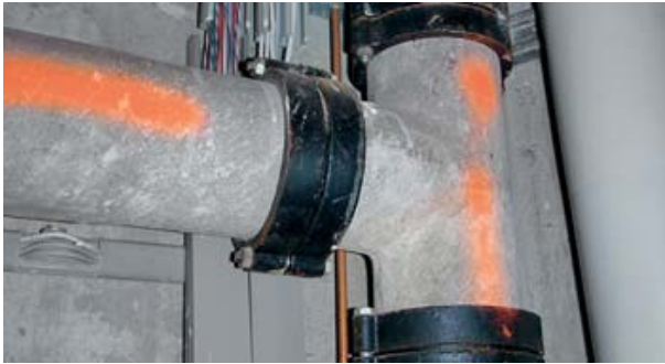
Asbestzementrohr
