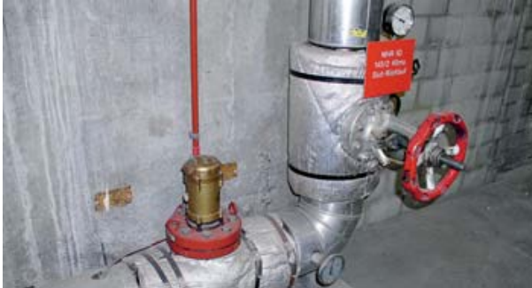
Asbestkissen für die Hitzeisolation
