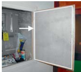
Asbesthaltige Brandschutzplatte
