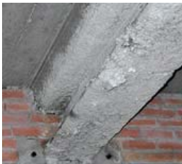
Spritzasbestisolierung
