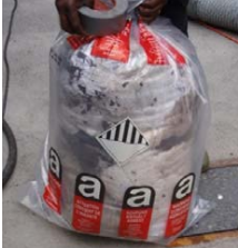
Abfälle aus schwachgebundenen Asbestmaterialien staubdicht in reissfestem Kunststoff sack verpackt.
