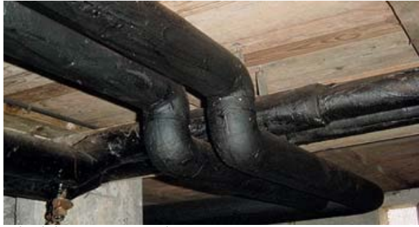
Asbesthaltiger Bitumenanstrich
